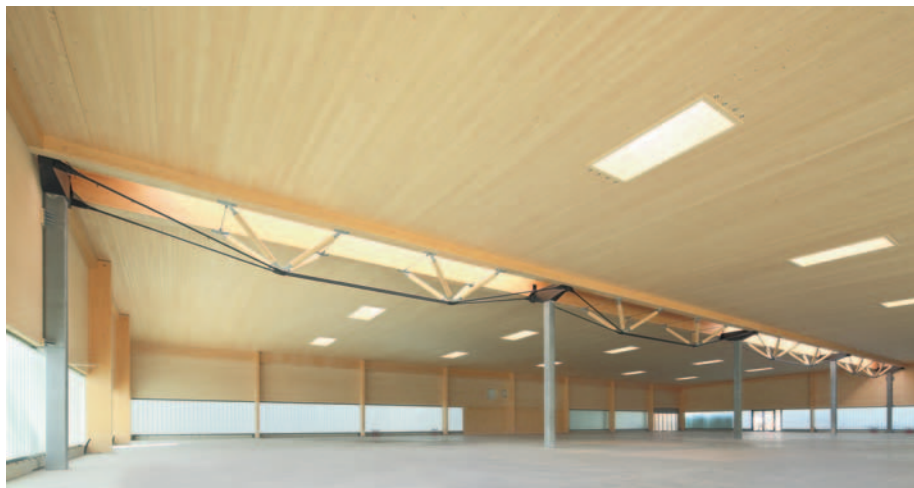
Gebäudespannweiten von bis zu 27 Meter lassen sich mit dem System Kielsteg direkt als Einfeldsystem realisieren.
