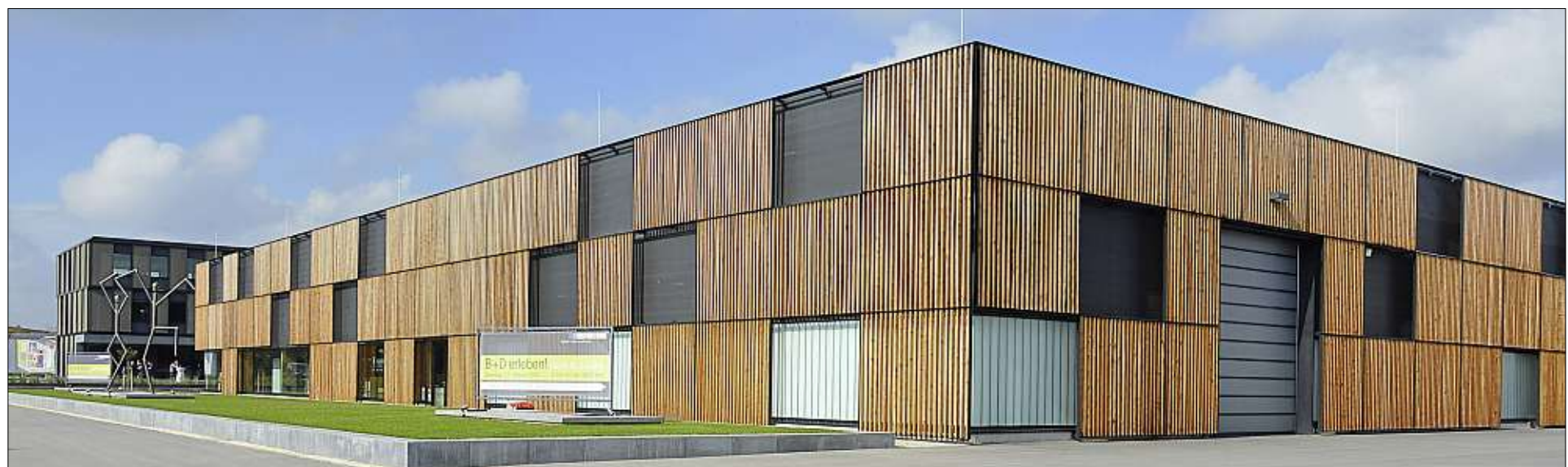
Die nahezu vollständig hölzerne Hallenkonstruktion des Innenausbauerspezialisten Baierl + Demmelhuber (B+D) kommt mit nur drei Innenstützen aus und ist ansonsten auf einer Gesamtgröße von 66 x 46 Meter freitragend. Das Konzept wurde nun ausgezeichnet.
