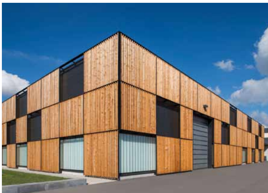
Das neue Hallengebäude spiegelt den Anspruch an die hochwertigen Innenausbauten von baierl + demmelhuber im Außensdesign wider.
