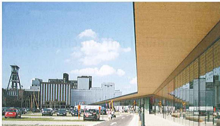
Der Architekt Frederik Vaes setzte im Retail Park mit seiner Materialwahl Glas und Holz Akzente zur Stahl- und Backsteinoptik der umliegenden Minenbauwerke.
