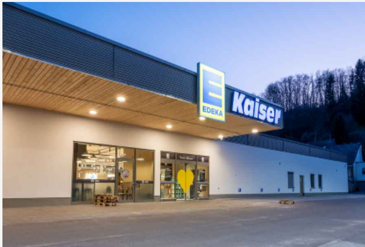
Das Kielsteg Dach überkragt den Eingangsbereich um 6,5 m – ohne Stützen
